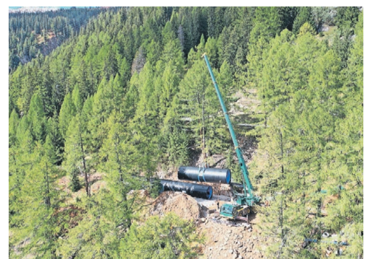
Transport. Vergangene Woche wurden die vorproduzierten Elemente auf die Baustelle im «Lengcheer» geliefert.
