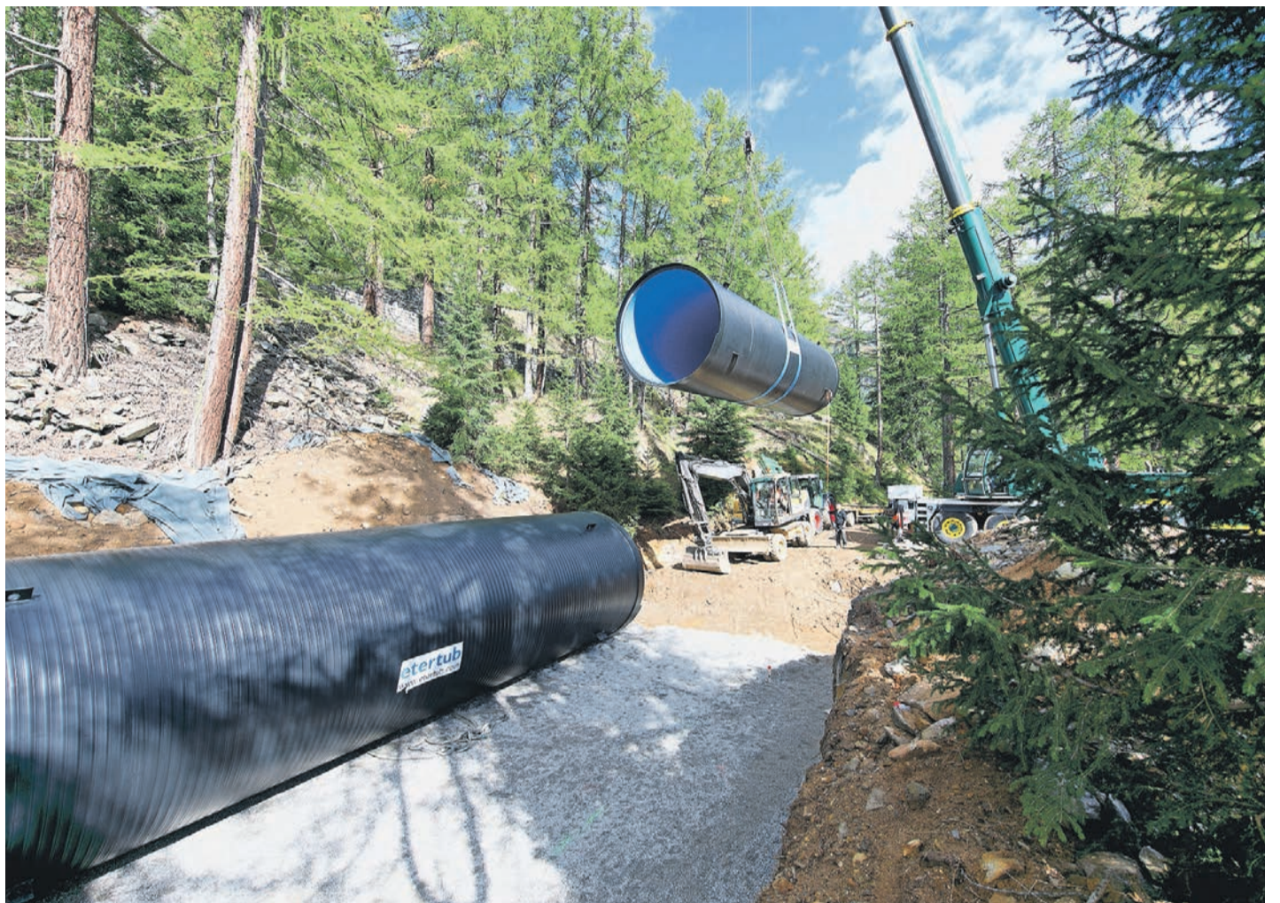
Kunststoff statt Beton. Das Fertig-Reservoir oberhalb von Oberwald fasst bis zu 300 000 Liter Wasser.
