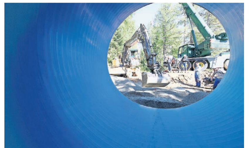
Handarbeit. Die einzelnen Elemente der bis zu 23 Meter langen Röhren werden in diesen Tagen zusammengesweisst.
