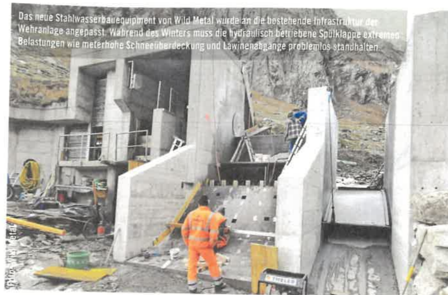
Der erheblich verringerte Sedimenteintrag im dreifach turbinierten Triebwasser der Kraftwerke Mund beweist, dass sich die Modernisierung der Wasserfassung bezahlt macht.
